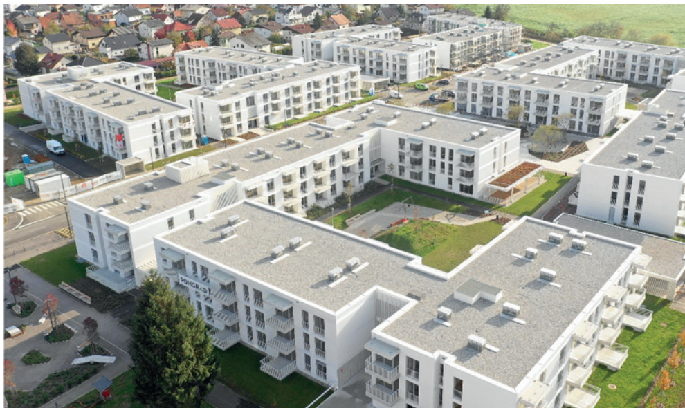
Slika 3: Ravne strehe so pripravljene za večjo sončno elektrarno zunanjega investitorja.
