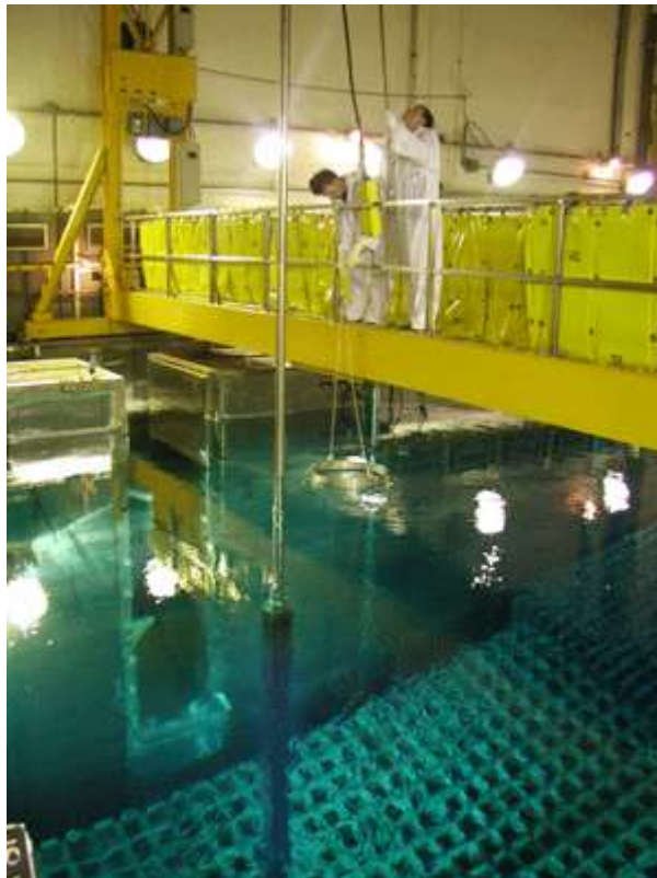
Slika 4: Bazen z izrabljenim gorivom
