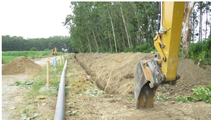
Slika 23: Izvedba cevovoda za dotok vode v bazene (Bombek, 2014)
