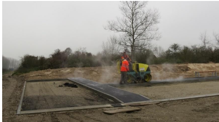
Slika 20: Asfaltiranje parkirišča za obiskovalce (Bombek, 2014)
