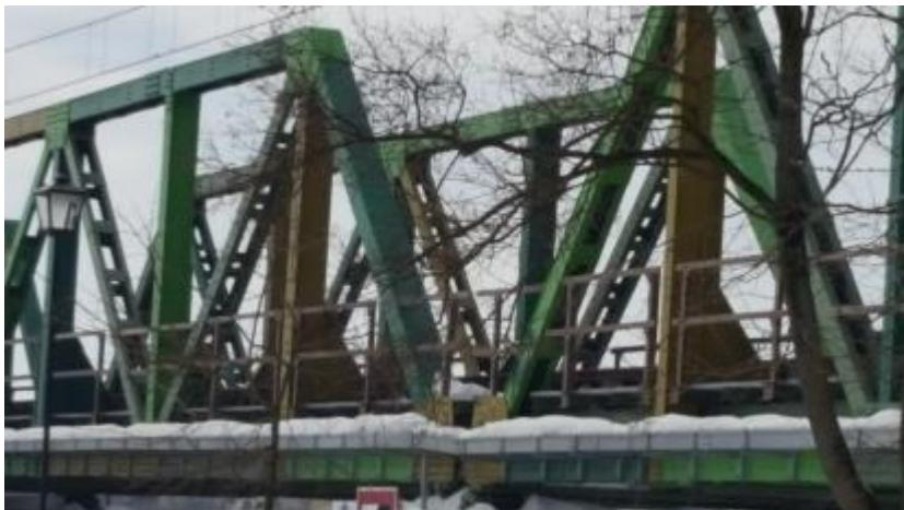
Slika 40: Palična konstrukcija. (Avtorica: Neja Škrjanec, 2018).
