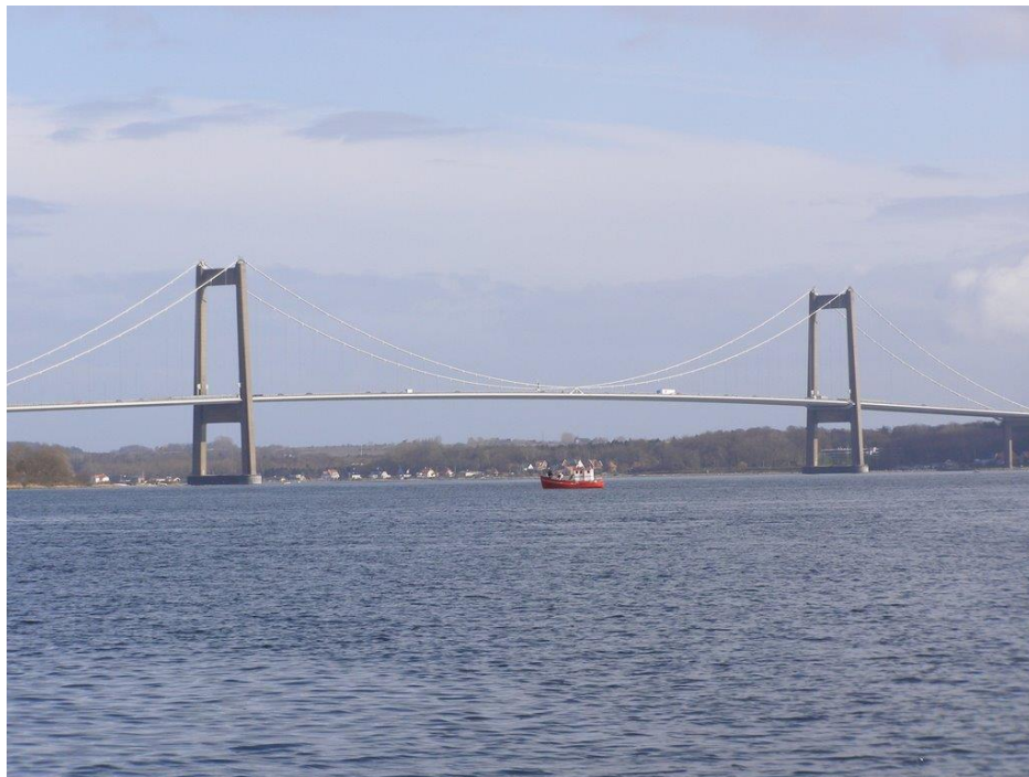
Slika 5: Most s poševnimi zategami.
