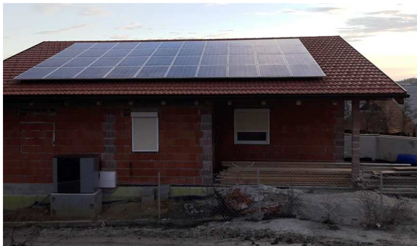
Slika 8: Izbrana sončna elektrarna. (Avtor: Miha Sterkuš, Razgor pri Žabljeku, 12. januar 2018)
