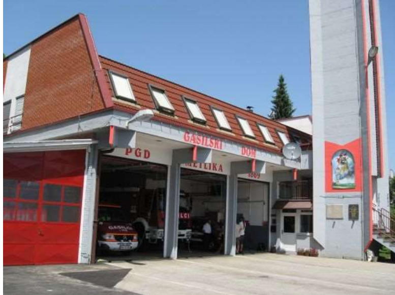
Slika 1: Gasilski dom Metlika danes. ( Gasilci-jubilej , 2009)
