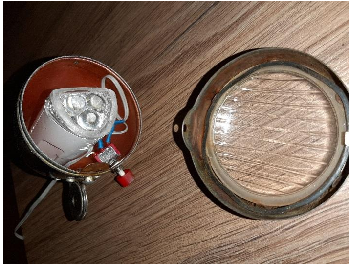
Slika 24: Vgradnja sodobne svetilke v starinsko ohišje (2. OŠ Slovenska Bistrica, 17. 12. 2019)
