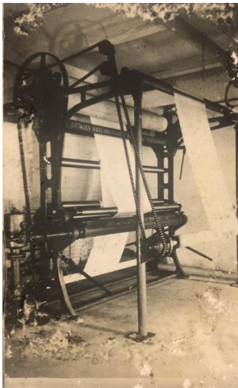
Slika 18: Tiskarski stroj podjetja »Zittauer Maschinenfabrik«. (Koren, J., b. d.)
