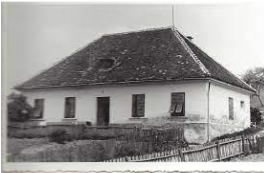
Slika 1 Prva šolska zgradba od leta 1842 do 1884. (Šolska kronika 1958–1970)
