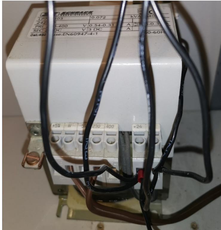
Slika 5 Napajalnik, ki pretvori 230V izmenične napetosti v 24V enosmerne napetosti (vir: lasten)
